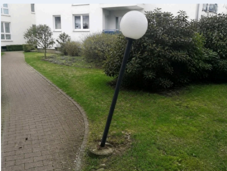
Bild 4 – Lose Mastleuchte; Neubefestigung und Prüfung sind beauftragt.
